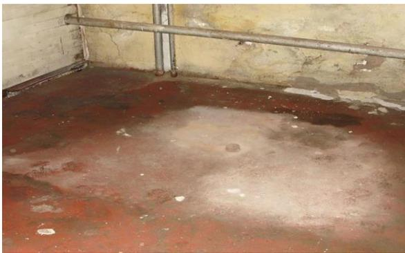
对地下室墙角，裂缝，还有和 post 接缝处抹沥青胶，减少地下气体进入室内。
